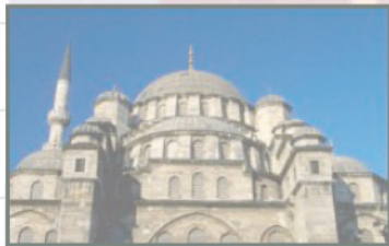
Exterior de Yeni Cami
